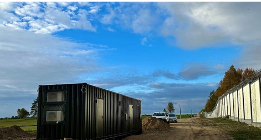
Kontener obsługi bariery elektronicznej [fot. POSG]
